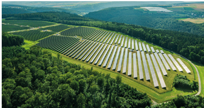
Der Solarpark der EnBW ist Teil des aktuell größten Solarpark-Komplexes in Baden-Württemberg, in dem sich zwei PV-Freiflächenanlagen eine Infrastruktur teilen.
